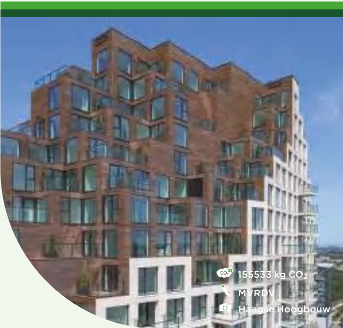
Tours résidentielles The Roofs Un bardage fermé installé au sommet des bâtiments - (2200 m²) La Haye, Pays-Bas
